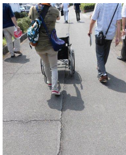
路面状況の確認
